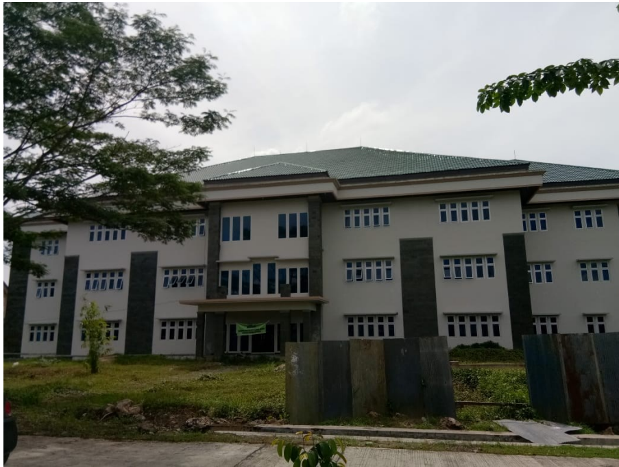
Gambar 94: Progress penyelesaian gedung Pascasarjana menggunakan dana APBN 2016 dan 2018.
