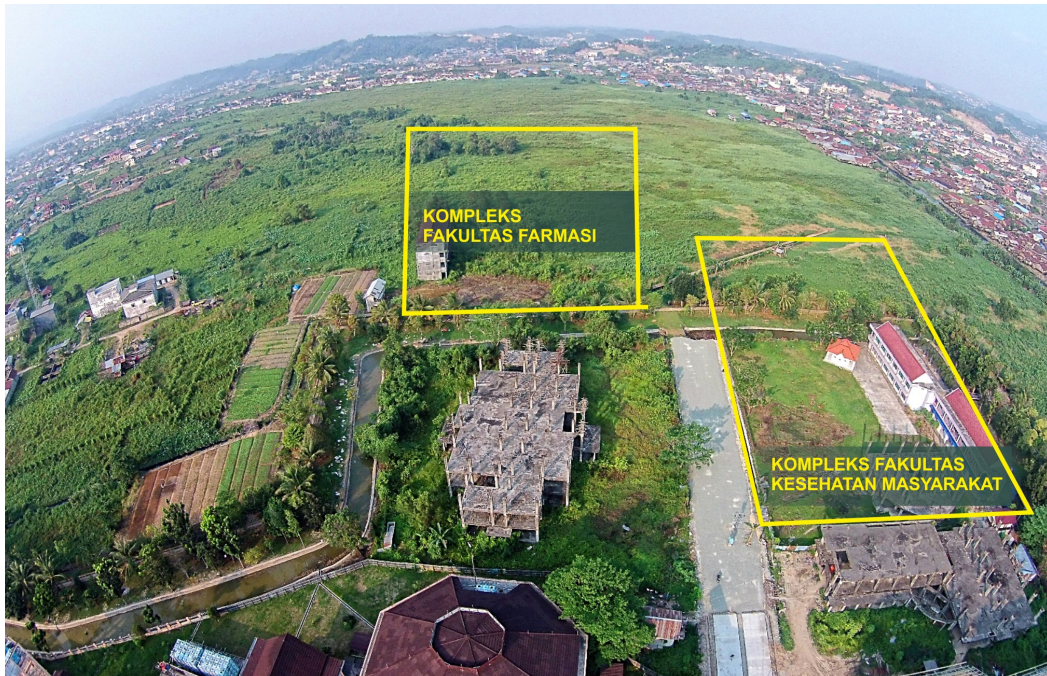
Gambar 112 : Lokasi pembangunan Laboratorium Farmasi dan Laboratorium Kesehatan Masyarakat
